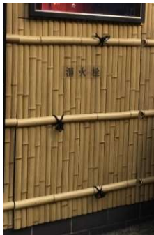
▲景観に配慮された消火栓
