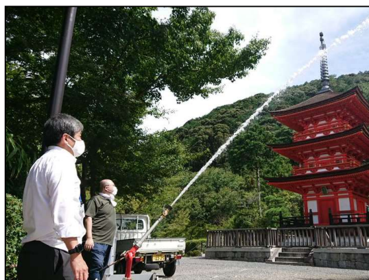
▲消防設備見学・実技体験
