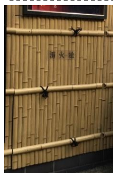
▲ 景観に配慮された消火栓
